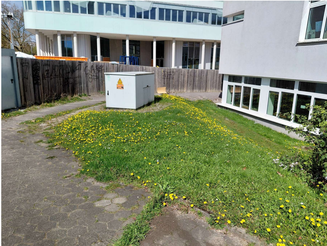
Abbildung 19: Der Trafo steht dem AN für die Baustromversorgung zur Verfügung und ist im Rahmen der Abbrucharbeiten zu schützen.
