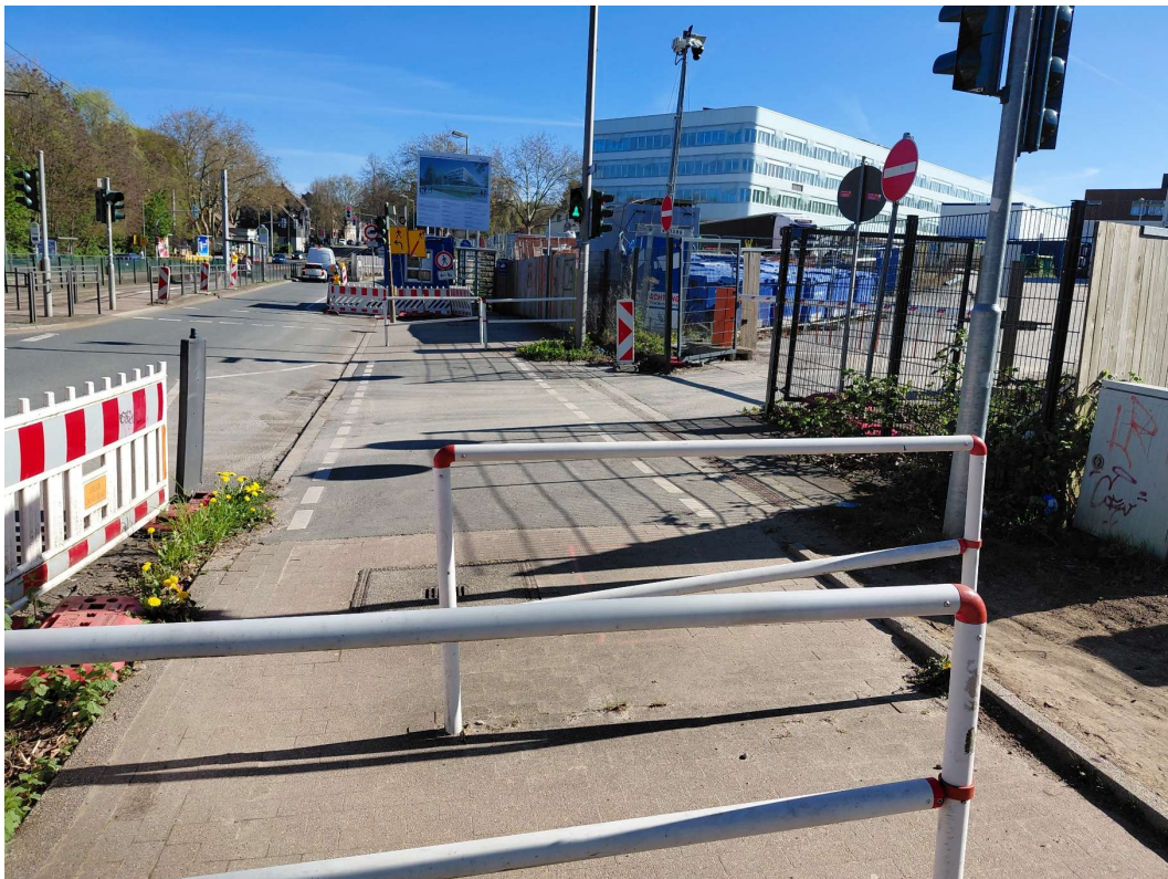
Abbildung 2: Blick entlang des Castroper Hellwegs in Richtung Nordosten. Rechts im Bild ist die Baustellenausfahrt zu erkennen. Die Ausfahrt ist mit Drängelgittern und einer festen Ampelanlage gesichert.
