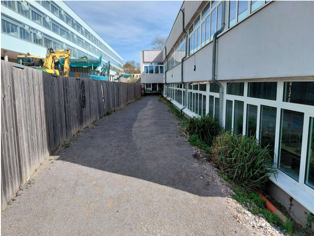
Abbildung 3: Blick entlang der nördlichen Baufeldgrenze in Richtung Osten. Rechts im Bild das Abbruchgebäude. Links im Bild der Schulneubau. Der Bauzaun wird vor Abbruchbeginn gedreht und ca. 2 m weiter Richtung Schulneubau auf die dahinter befindliche Böschung gestellt. Der in der Bildmitte erkennbare Gebäudevorsprung ist vorlaufend abzubauen, um die temporäre Baustraße zur Erschließung des östlichen Baufelds herstellen zu können.
