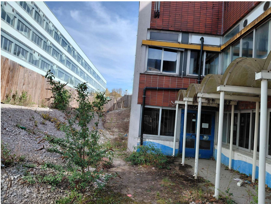
Abbildung 4: Blick entlang der nördlichen Baufeldgrenze in Richtung Osten zwischen den beiden vorlaufend zurückzubauenden Gebäudevorsprüngen. Auf dem Bild ist zu erkennen, dass durch die temporäre Baustraße ein Geländesprung von ca. 3 m Höhe überwunden werden muss.
